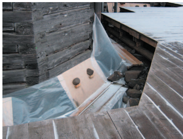
фото 10. Консервация столбчатых фундаментов
