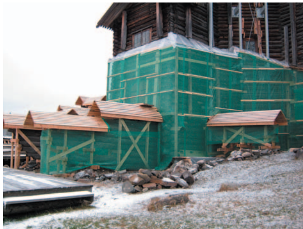
фото 9. Трапезная после демонтажа
