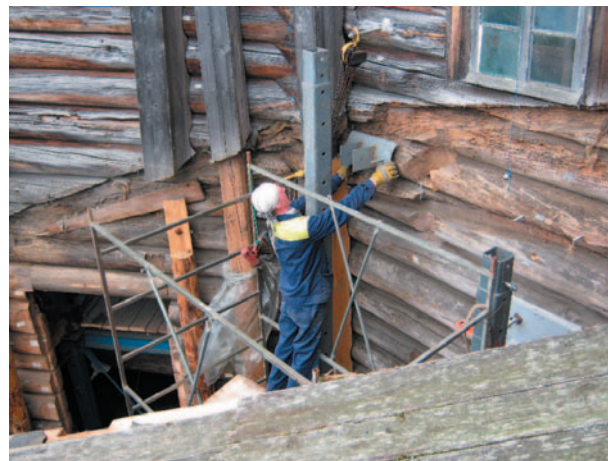
фото 4. Монтаж систем лифтинга
