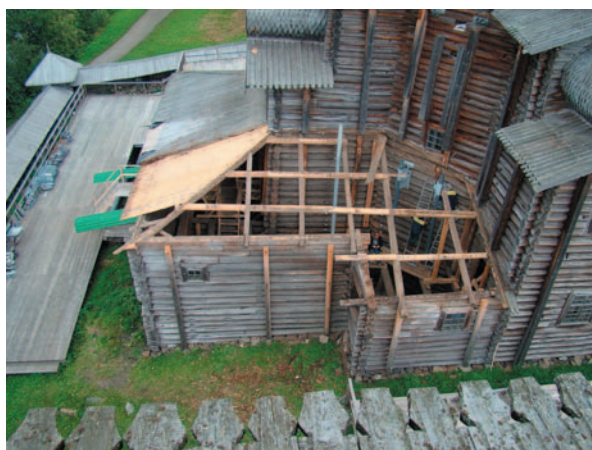
фото 8. Процесс демонтажа трапезной
