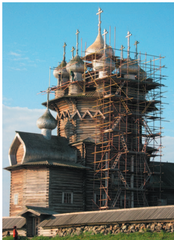
фото 14. Покровская церковь в процессе реставрации главок и кровли
