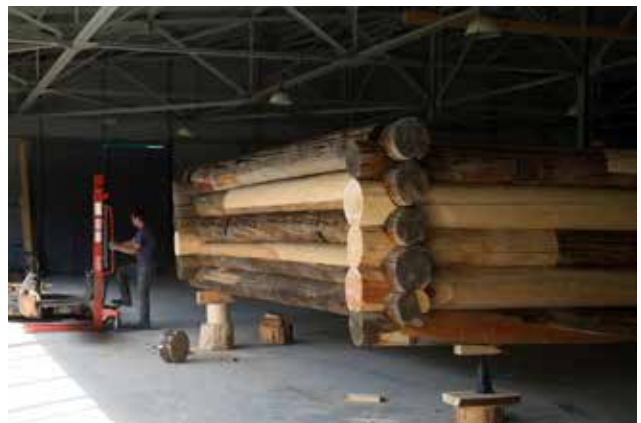
Предварительная сборка отреставрированного сруба
