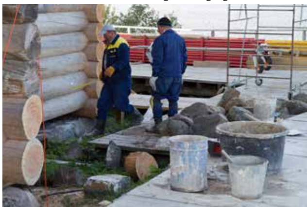
Устройство каменной кладки под стенами сруба
