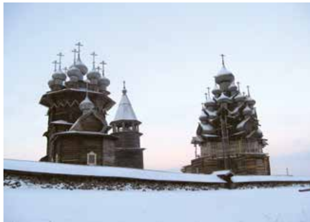
Общий вид Кижского погоста. Январь, 2014
