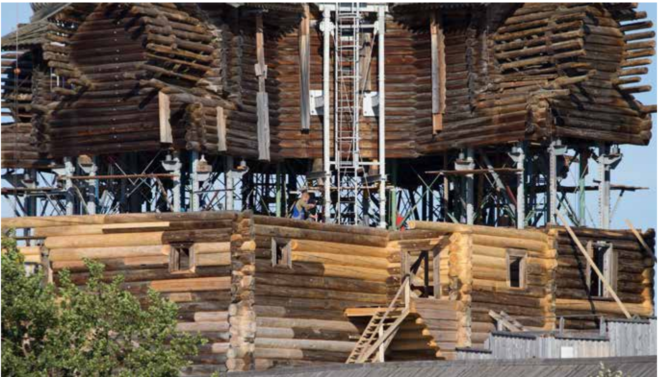
Сборка отреставрированного сруба на погосте
