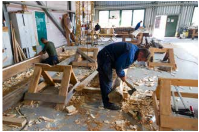
Ремонт бревен в Реставрационном комплексе
