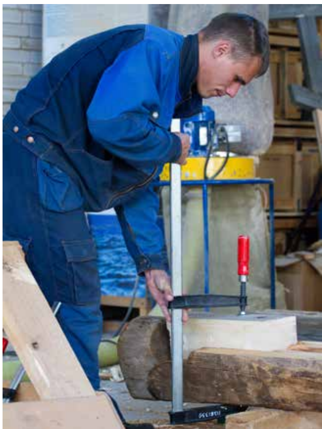
Ремонт бревен плотником-реставратором Плотницкого центра Василием Вареновым
