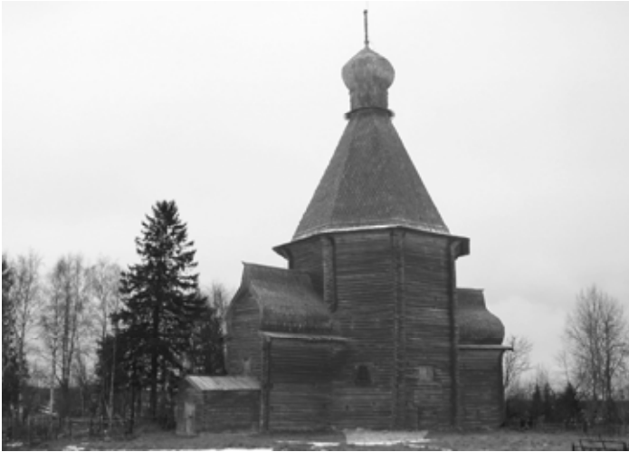
Рис. 1. Никольская церковь, село Лявля. Фотография 2017 г. Из архива АМДЗ
