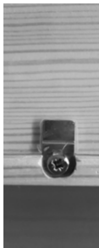
Рис. 13. Крепление плексигласа к планкам подрамника
